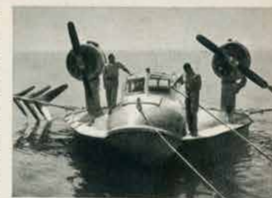
L' "XCH-4", un aliscafo sperimentale della U. S. Navy di circa 10 anni fa. Le alette, completamente immerse, ma sollevabili, ricordano quelle del Forlanini.
